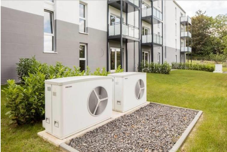
Zwei außen aufgestellte Luft-Wasser-Wärmepumpen WPL 25, die ein Neun-Wohneinheiten-Gebäude in Würselen beheizen. Fotos: Stiebel Eltron
