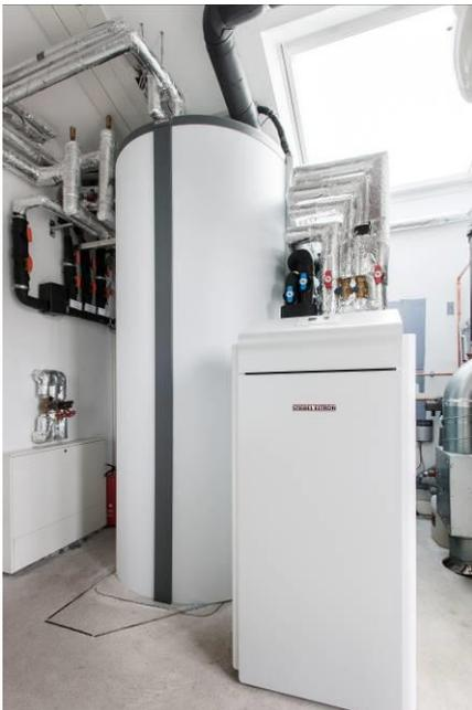
Die Erdreich-Wärmepumpe WPF gewinnt ganzjährig Wärmeenergie aus Tiefenbohrungen. Foto: STIEBEL ELTRON
